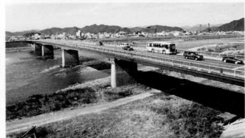
金華橋 昭和39年10月竣工 橋長301.6m 幅15m 事業費4億6000万円
