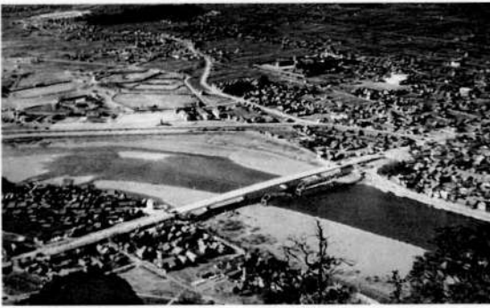
長良橋 新橋と取り壊される旧橋を上空より撮影
