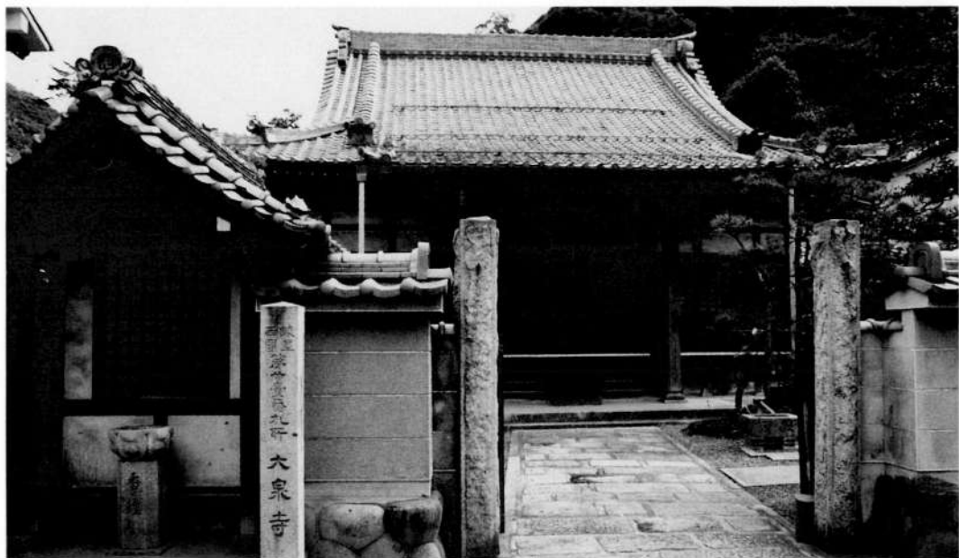
昭和初期に再建された大泉寺（万力町）
