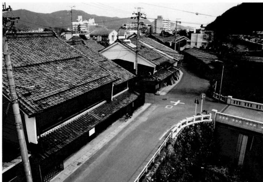
美登里橋（昭和29年3月竣工）から見た元浜町の町並み
