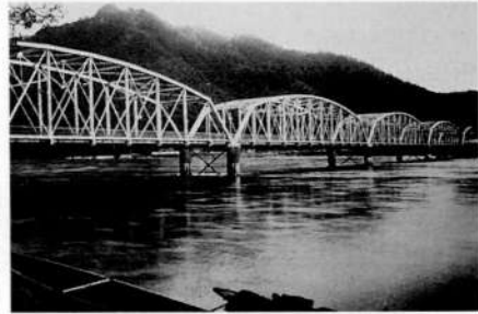
長良橋旧橋 大正4年架設 板張り鋼構橋
