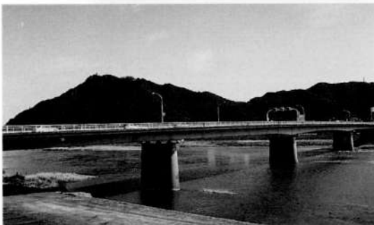
金華橋 修景照明 昭和63年6月30日設置 施工費1360万円 ランプ20灯 日没に点灯、午後10時消灯
