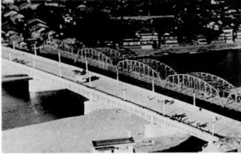
昭和31年10月 地元とのトラブルも多かった、新旧長良橋
