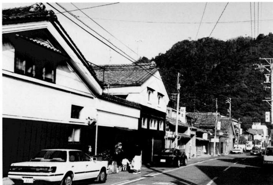
白壁の土蔵が残る益屋町の町並み（北側）
