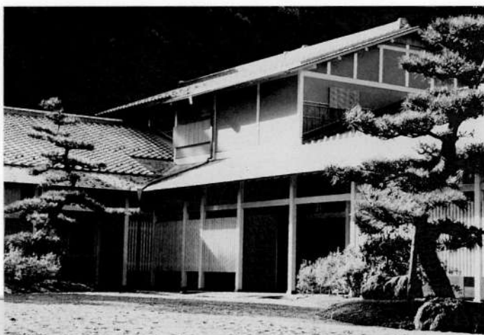
来園者休憩所全景
