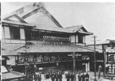
伊奈波から移築した岐阜劇場
