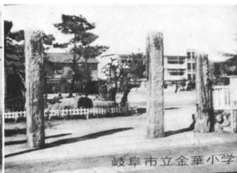
第2期工事完成 43年2月15日 第1期の西の5教室
