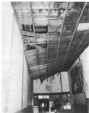
学校の廊下の天井も落ちた
