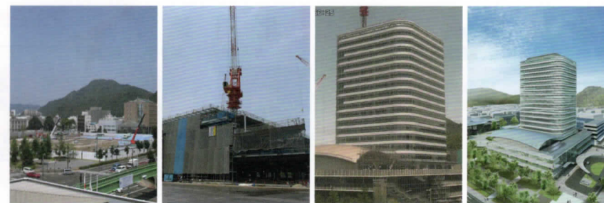
▲平成30年6月の建設現場 基礎工事を行うための掘削が行われています。 ▲令和元年6月の建設現場 5階床までの躯体(建物の構造を支える骨組み)の施工が完了しました。 ▲令和2年6月の建設現場 階層も高くなってきています。 ▲完成イメージ 新庁舎開庁まで1年を切りました。楽しみです。
