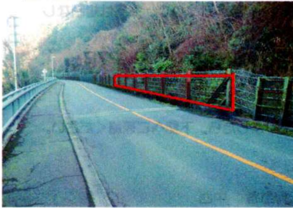
落石防護柵更新1
